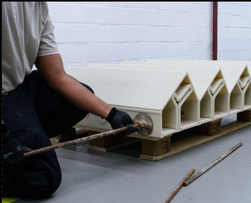
Modulare 3D-gedruckte Treppenschalung.
